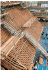
本殿大屋根の修繕
