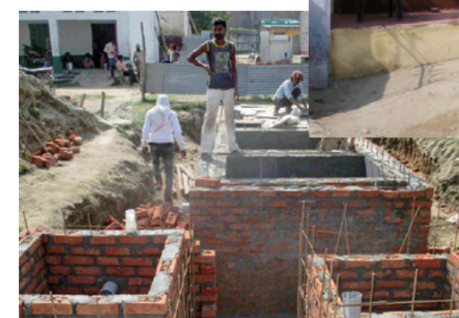
JICA事業で設置された環境配慮型トイレの升型消化室(バラナシで)
