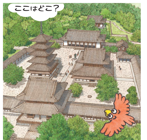
＜ヒント＞奈良県にある世界最古の木造建築物 (イラスト 黒澤 達矢)
