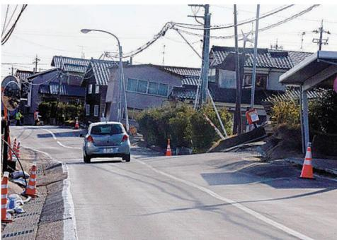
地震による液化化被害で道路が波打ち、建物がたむいた石川市内
