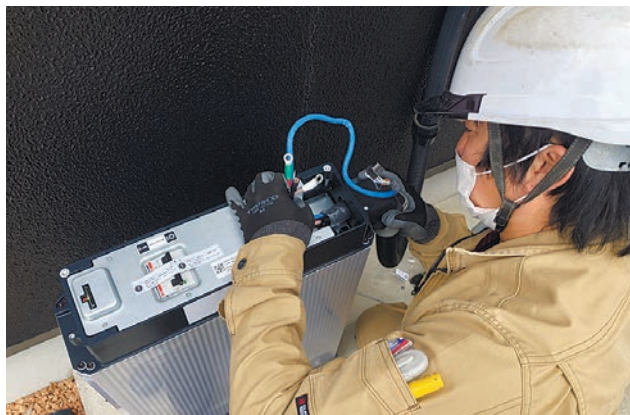
蓄電池設置工作業中の坂本さん。有給も時間単位で取得でき活用しやすい
